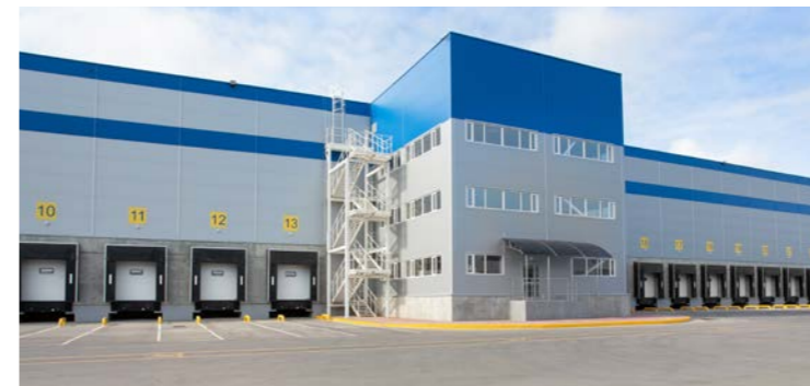
Московский Проекторный Завод, г. Москва Решение для энергоснабжения испытательного цеха
