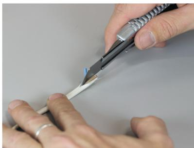
**3** Разделите внешнюю оболочку по всей длине надреза (при необходимости ее можно аккуратно подрезать изнутри) и обкусите бокорезами ненужный кусок. Если используете нож, заверните разрезанную часть оболочки назад, отогните жилы в противоположную сторону и осторожно отрежьте ненужную часть оболочки, стараясь не задеть ножом изоляцию жил.
