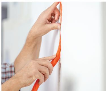
**3** Проложите кабель в гофрированной трубе в паз, подведите его к месту установки розетки и вставьте в монтажную коробку, удалив заглушки. Кабель в штробе приморозьте алебастром с интервалом 20–30 см.
