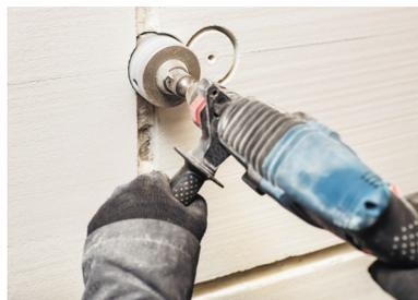
**1** Разметьте на стене трассу проводки и место розетки. Проштробите паз для проводки. Это можно сделать либо зубилом и молотком, либо перфоратором, либо болгаркой. Ширина и глубина штробы не должны превышать 25 мм. В кирпичной стене паз обычно делают на всю глубину штукатурки.
