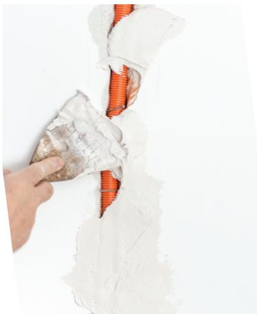
Для того чтобы уложить проводку под штукатурку, сначала нужно разметить маршрут на стене. Для одного кабеля припуск на паз составит около 25 мм. Для наиболее трудоемкой части работы — подготовки паза — понадобятся камнетесное и слесарное зубила. С помощью первого инструмента сделайте края паза, а второе понадобится для удаления штукатурки в нем. Также сделайте отверстия для монтажных коробок, в которые будут установлены розетки или выключатели.
