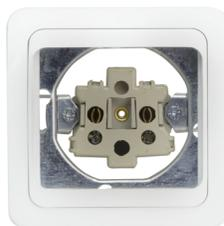
**6** Обрежьте провод, оставив небольшой запас, зачистите концы и подсоедините к соответствующим контактам розетки. Вставьте розетку в коробку и закрепите ее с помощью винтов или раздвижных лапок.
