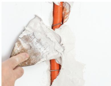
**4** Установите коробку в гнездо на чистый алебастр и выровняйте заподлицо со стеной. Закрепите коробку алебастром, добавляя его в пустоты вокруг коробки, но оставляя свободными заходящие внутрь провода. Штробы и стену вокруг монтажной коробки выровняйте гипсовой штукатуркой.
