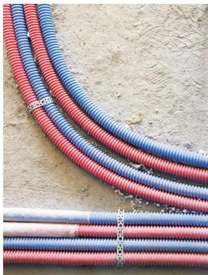
труб диаметром от 25 мм. В них укладываются кабели, соединяющие распределительные коробки в разных помещениях между собой и с общим распределительным щитком (квартирным или этажным). Провода в трубе протягиваются на 20–25 м. При этом необходимо ограничить количество поворотов (выложенных углов) — их должно быть не более двух-трех.
