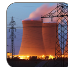
Объекты энергетической отрасли
