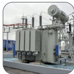
Объекты энергетической отрасли
