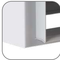
Полностью проваренные швы
