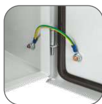
Варенные омедненные шпильки заземления с поводком. Закрепленный поводок заземления
