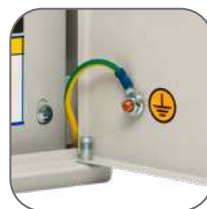
Обмедненные шпильки. Закрепленный поводок заземления
