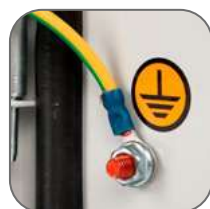
Обмедненные шпильки. Закрепленный поводок заземления
