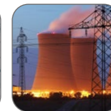
Объекты энергетической отрасли
